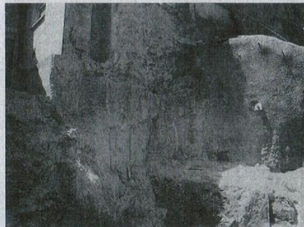
„Betonamit geht normalerweise den Weg des geringsten Widerstands, somit arbeitete man sich Schritt für Schritt auf die jeweiligen Häuser zu“, wird berichtet. Parallel wurde der bleibende Hang mit Spritzbeton versehen.
